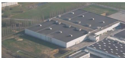
Chaufferie bois-énergie de SITPA 4
