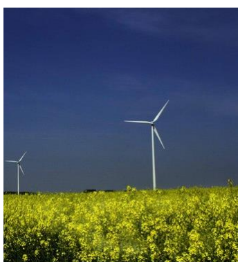
Parc éolien du petit arbre (Lihons) 1
