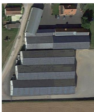
Toiture PV agricole (Foucaucourt) 2
